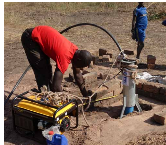
rozpoczęcie prac przy studni
